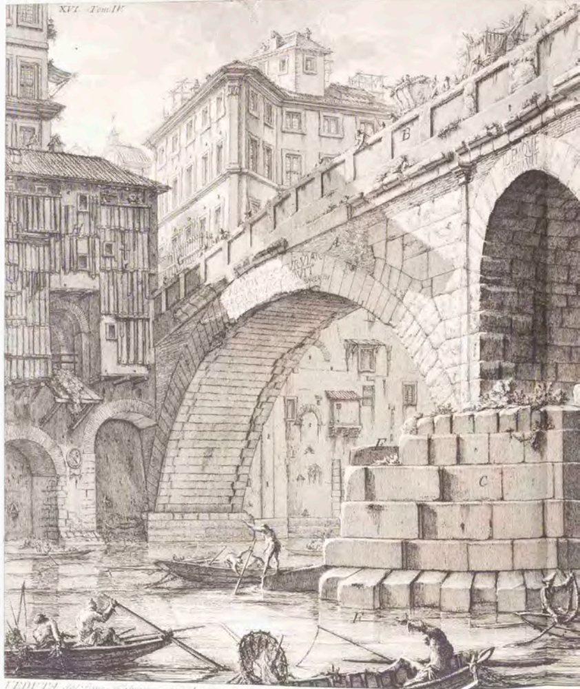
L'EDIFIZIO del Ponte Sisto, detto quattro Capri Quattro Capri è spogliato nel di sopra di cui sembra l'antico disegno. A. Ripetere moderno di marmo in sostituzione dell'antico archi B. Proprietà moderno di marmo e sp della via H. Sono segni e figure, e disegni di i vedono attenti a l'Antico del Ponte, come si veda nella esp. I. K. S.
